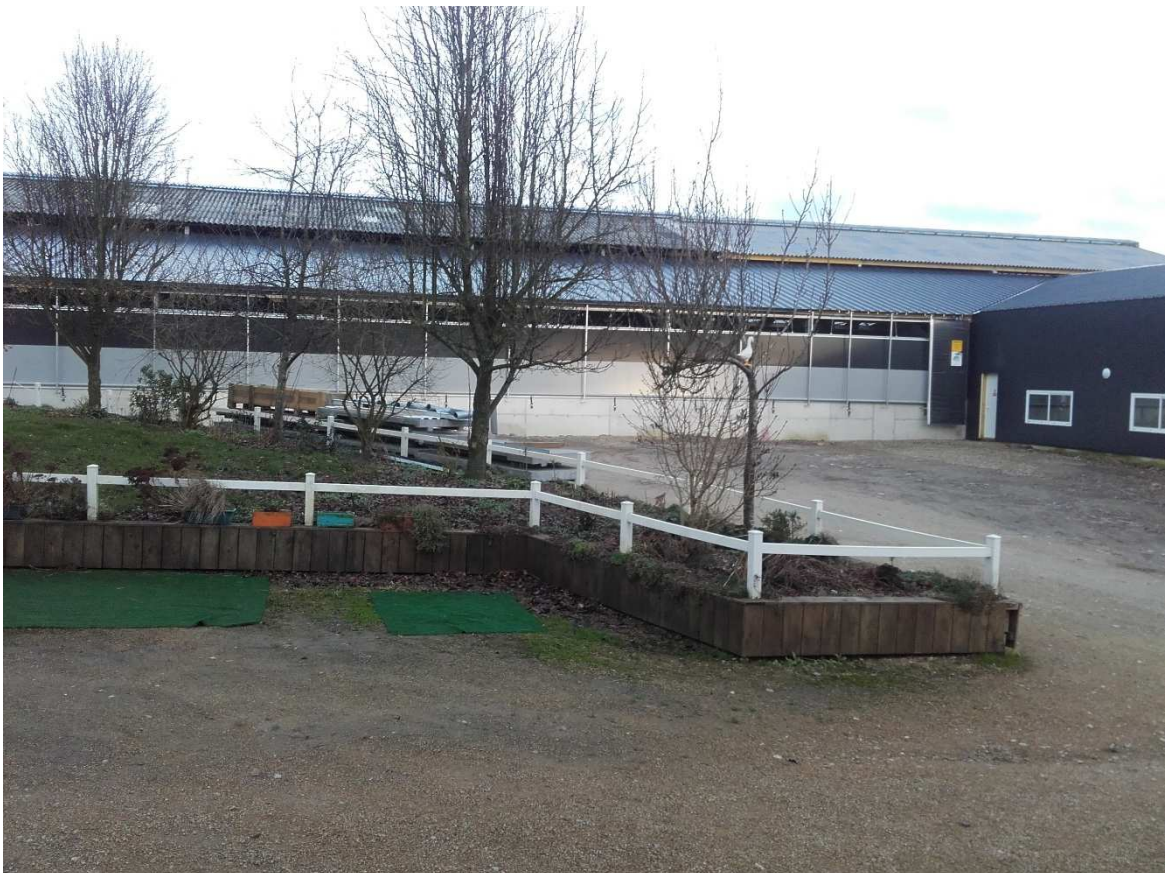
Photo n°3 : Vue côté Ouest
